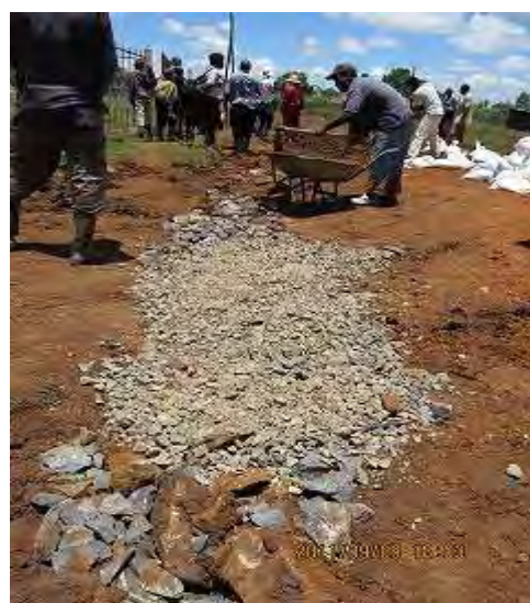
側溝を作っているところ。
